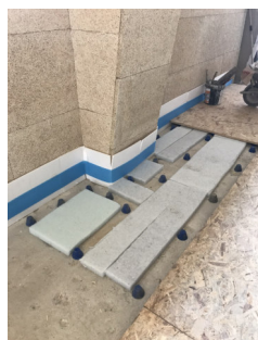
Palestra (1°p.): posa sistema Arco PLUS (Arco DAMPING, Arco FIBER), doppio pannello in legno OSB.
