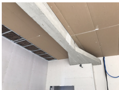
Aule (p.t.): posa pareti cartongesso, controsoffitto fonoisolante (Silentboard+TOPSILENTAdhesive+Diamant), impianti.
