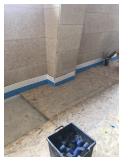
Palestra (1°p.): posa sistema Arco PLUS (Arco DAMPING, Arco FIBER), doppio pannello in legno OSB.
