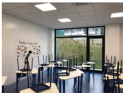
Ambienti finiti: aule (controsoffitto fonoassorbente Rockfon BLANKA) e palestra (contropareti/controsoffitto CELENIT).
