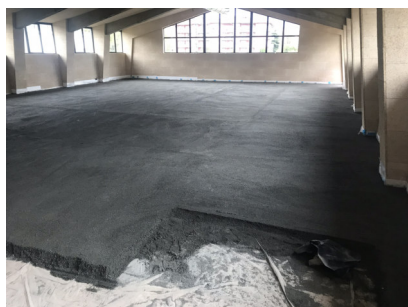
Palestra (1°p.): posa sottofondo ECOLIGHT, massetto sabbia e cemento, pavimento in gomma PAVISINT SL 75.
