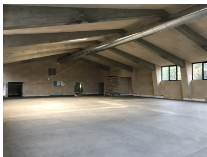
Palestra (1°p.): posa sottofondo ECOLIGHT, massetto sabbia e cemento, pavimento in gomma PAVISINT SL 75.
