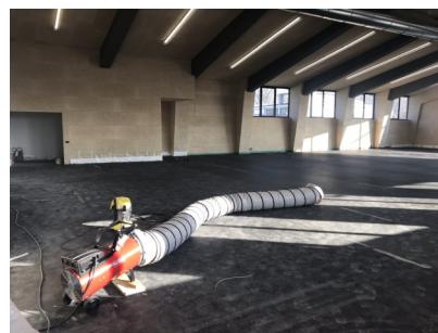
Palestra (1°p.): posa sottofondo ECOLIGHT, massetto sabbia e cemento, pavimento in gomma PAVISINT SL 75.
