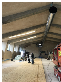
Palestra (1°p.): posa sistema Arco PLUS (Arco DAMPING, Arco FIBER), doppio pannello in legno OSB.
