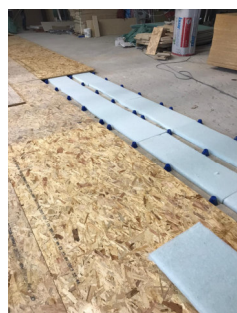
Palestra (1°p.): posa sistema Arco PLUS (Arco DAMPING, Arco FIBER), doppio pannello in legno OSB.
