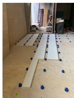
Palestra (1°p.): posa sistema Arco PLUS (Arco DAMPING, Arco FIBER), doppio pannello in legno OSB.
