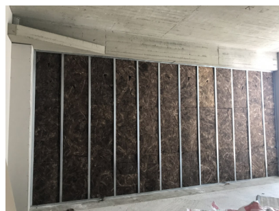
Aule (p.t.): posa pareti cartongesso, controsoffitto fonoisolante (Silentboard+TOPSILENTAdhesive+Diamant), impianti.
