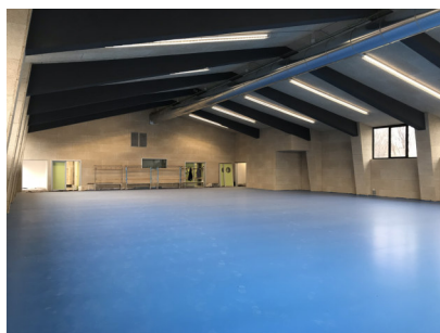
Ambienti finiti: aule (controsoffitto fonoassorbente Rockfon BLANKA) e palestra (contropareti/controsoffitto CELENIT).
