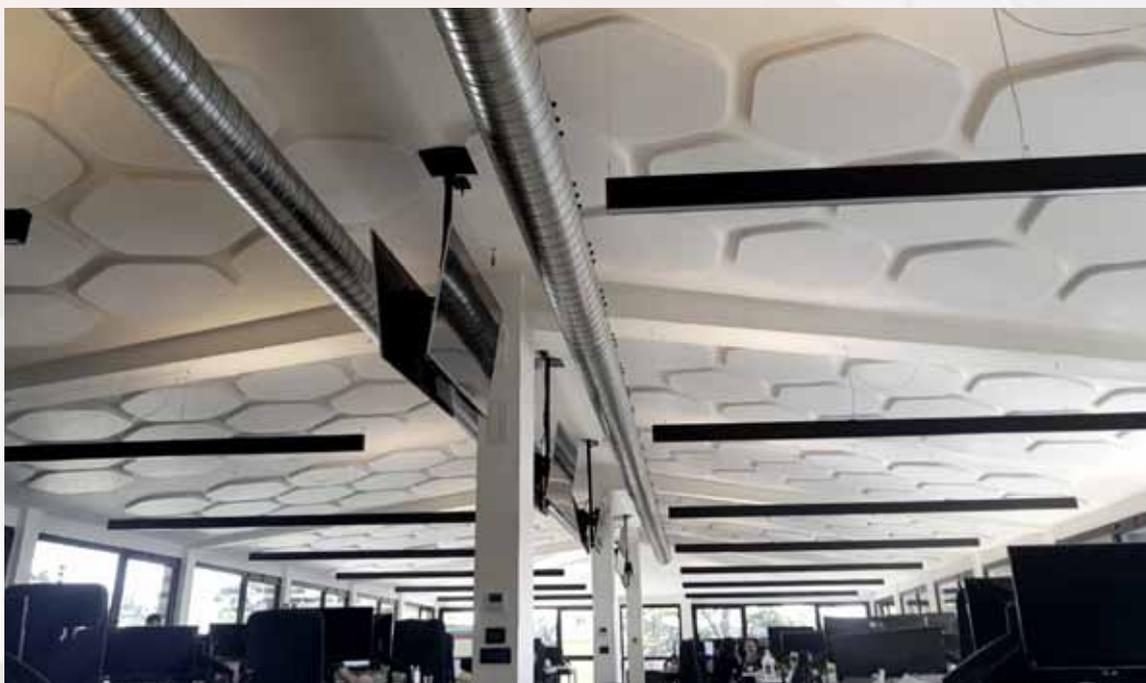
Pannelli Arco FORM di forma esagonale, applicazione direttamente a soffitto
