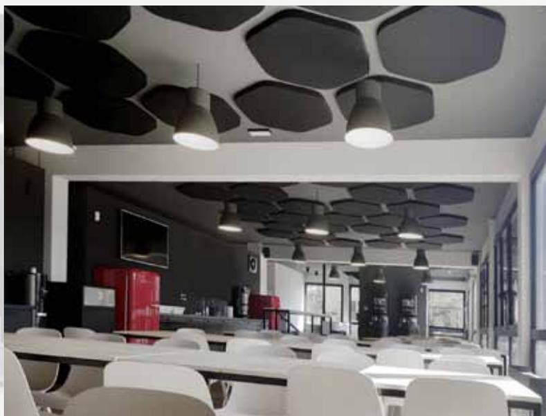
Pannelli Arco FORM di forma esagonale, applicazione direttamente a soffitto
