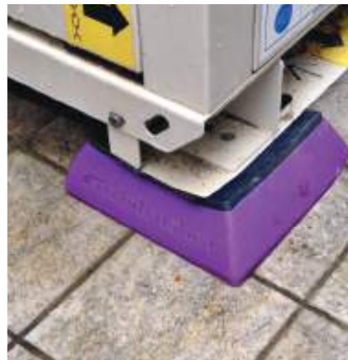
Particolare posizionamento supporto
