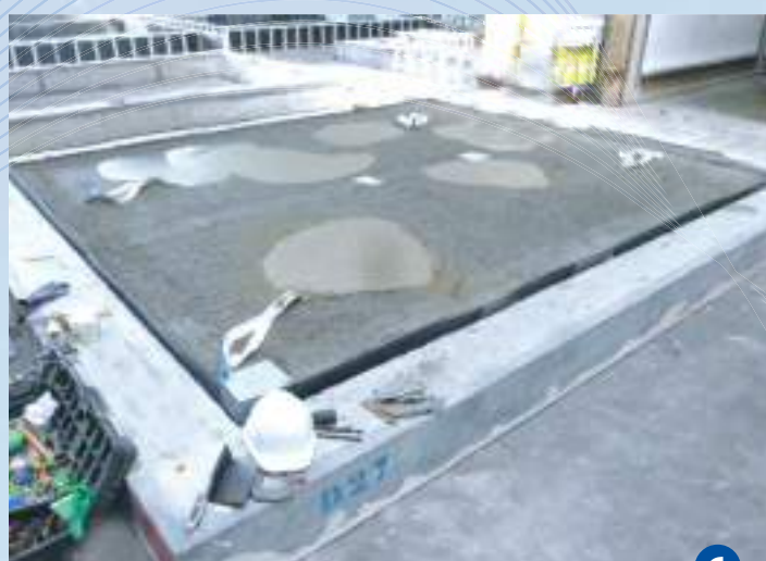
Staggiatura di livellamento del massetto per pavimento
