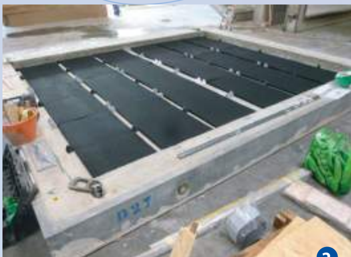
Applicazione dei pannelli Arco FIBER direttamente tra i supporti anti-vibranti.
