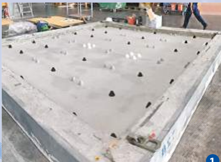
Tracciatura e posizionamento dei supporti Arco DAMPING sul solaio grezzo.
