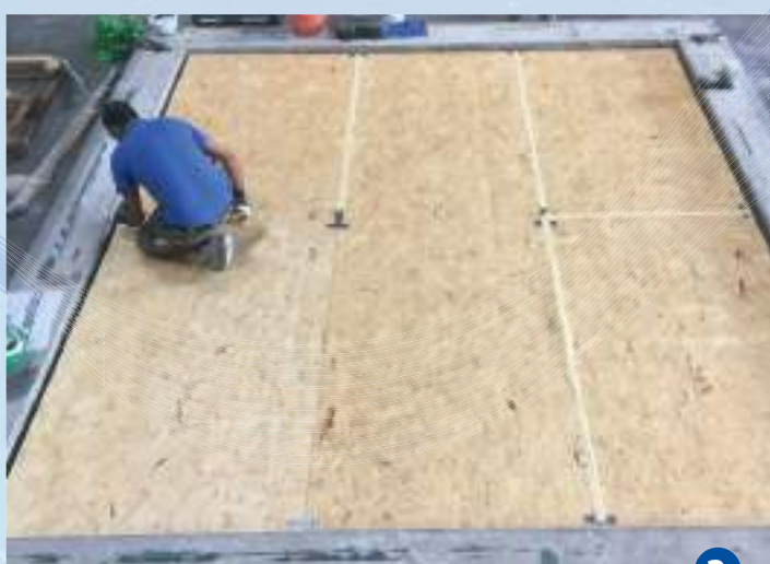
Applicazione ed unione rigida di tutte lastre di OSB posate sopra ai supporti anti-vibranti
