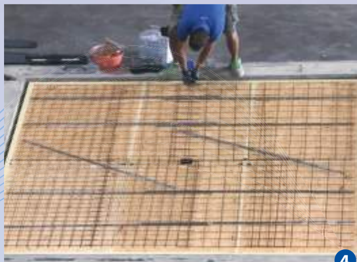
Armatura del sistema Arco PLUS con rete elettrosaldata e barre in acciaio.
