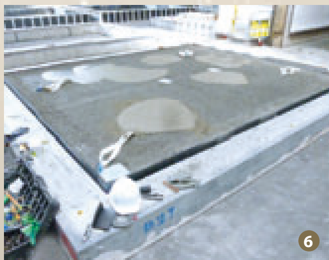
Staggiatura di livellamento del massetto per pavimento
