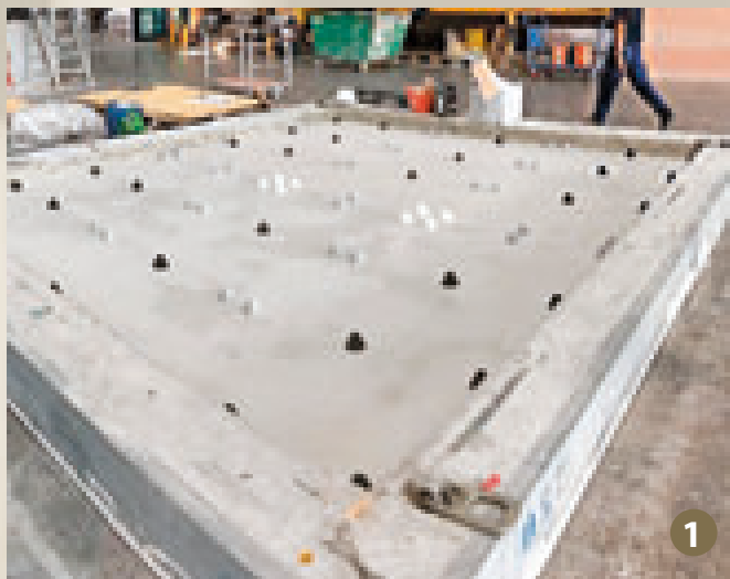
Tracciatura e posizionamento dei supporti Arco DAMPING sul solaio grezzo.
