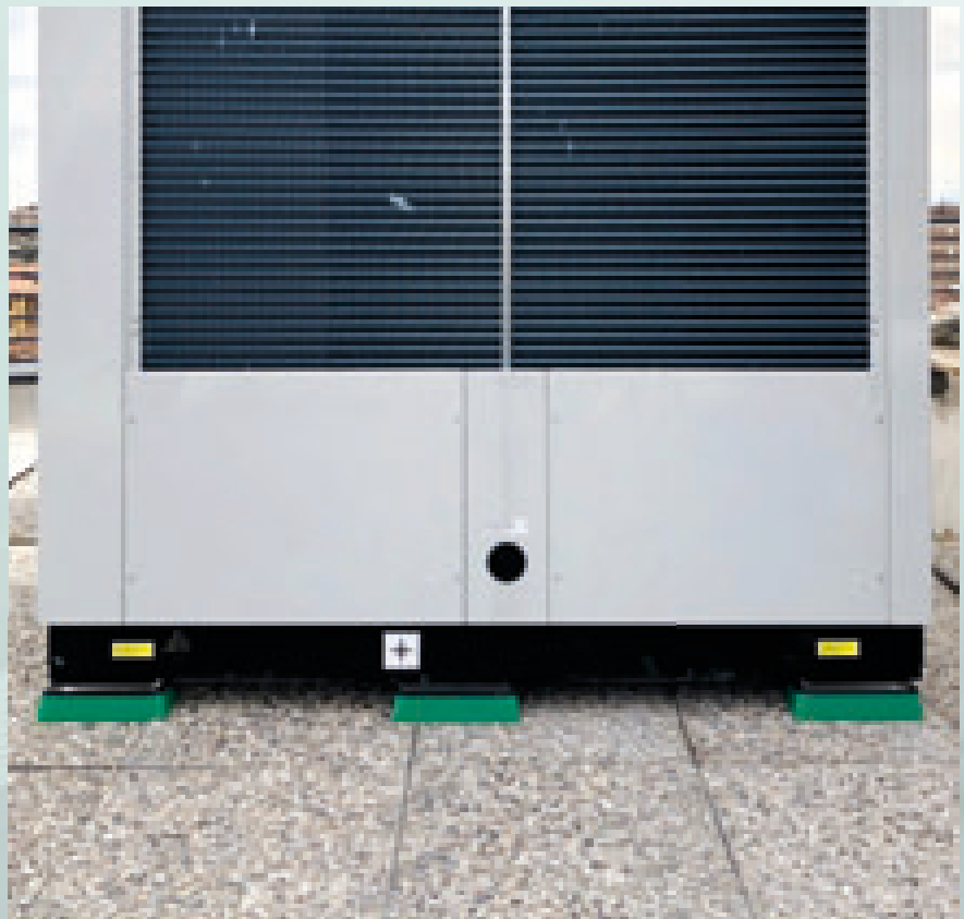
Arco Green Damping - forzante pompa di calore - provincia di Bologna
