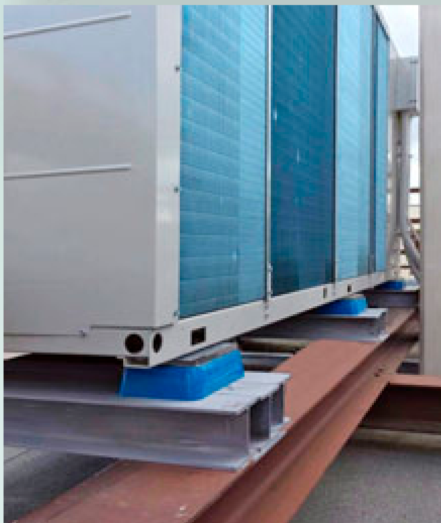
Arco Blue Damping - forzante pompa di calore provincia di Torino
